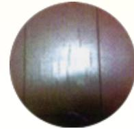
表面コート剤を施工することで、濡れ雑巾を使用しても良いと宣伝していたが、実際にはひび割れが発生。
